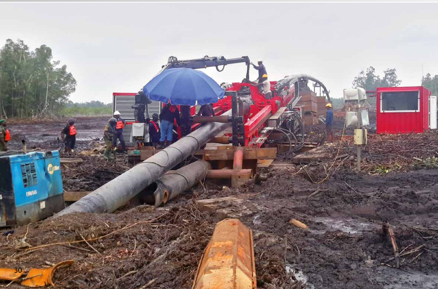
Установка ГНБ со встроенной системой продавливания труб
