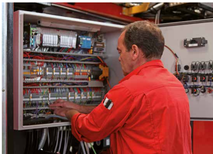
Электромонтаж в ограниченном пространстве
